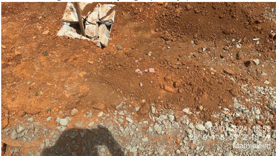
Figura 3 – Caixas de passagem (iluminação) danificadas.
